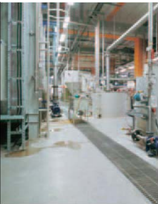
Protuklizni premaz sa Disboxid 444 Dickschicht u proizvodnoj hali.
