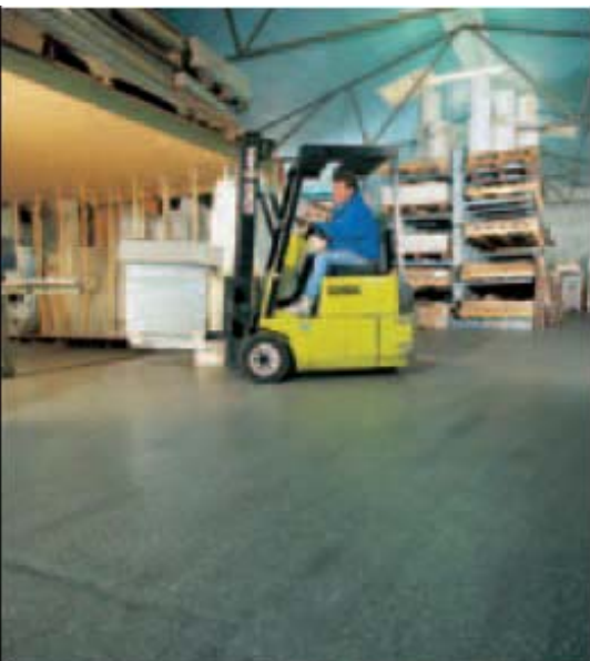
Disbopox 443 EP-Imprägnierung na jako brašnjavim podovima od cementnog estriha u prodajnoj hali.
