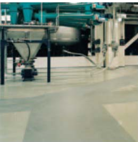
Prometne površine ovog proizvodnog pogona su premazane sa Disboxid 467 Hartkornschicht.
