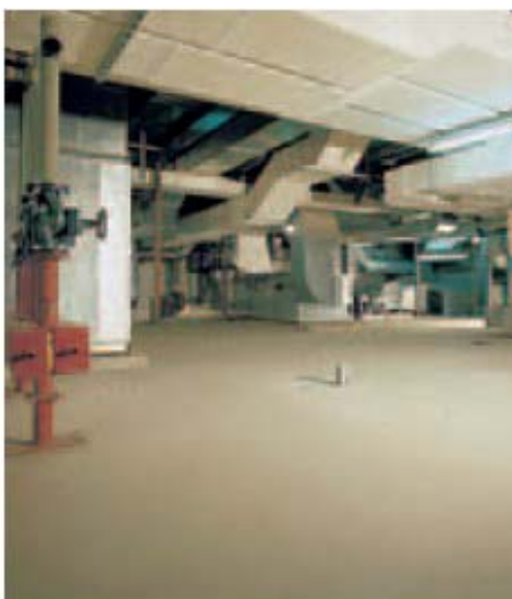
Površina lakirana u boji sa Disbopox 447 Wasserepoxid u toplinskoj stanici.
