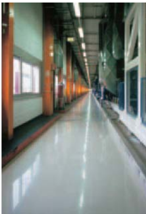
Na ovoj transportnoj stazi u hali za lakiranje nanešen je premaz samolivnog morta sa Disboxid 464 EP-Decksiegel.
